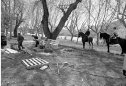
Miembros de la brigada municipal, trabajando en la reconstrucción de un banco del Ferial. FOTO: A.R.
